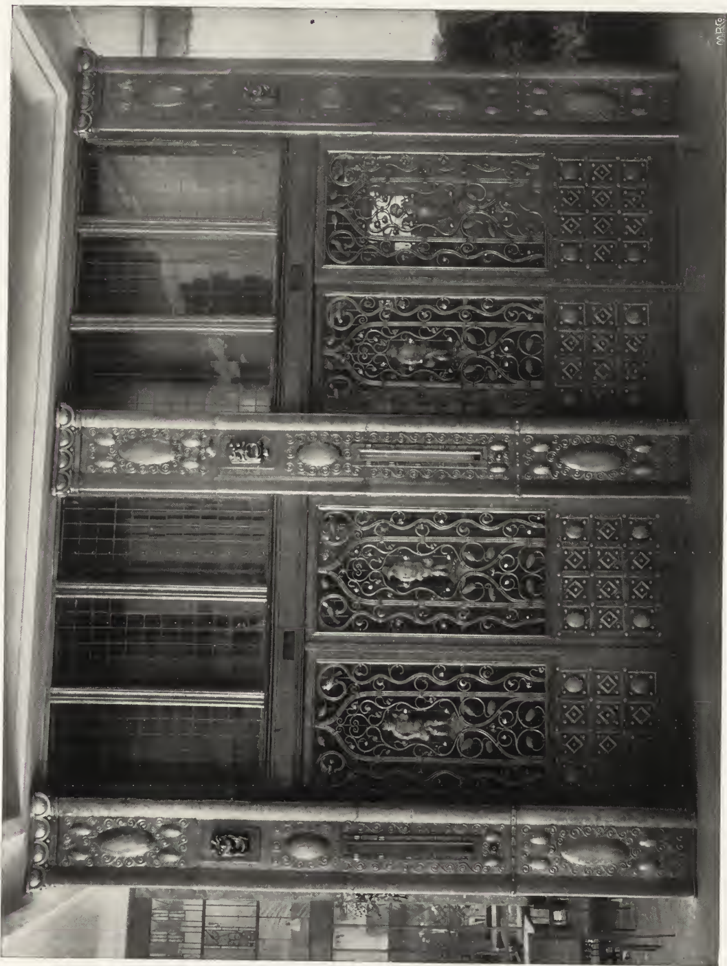
ARCHITEKT EMIL SCHAUDT. LIFT-UMBAU. KUNST-SCHMIEDE- ARBEIT VON STEI- NICKEN & LOHR MÜNCHEN.
